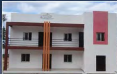
Bureau DRPEB Anôsy Taolagnaro
