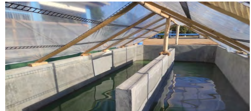
Infrastructure de production de spiruline mises en place par le Centre de Développement de l'Aquaculture (CDA/ Mahajanga)
