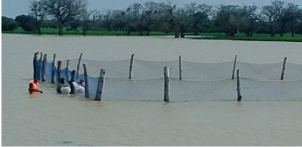
Enclos en filet, fermé sur les 4 côtés et sur le fond. L'enclos est maintenu par des piquets en bois (voir la figure 29)
